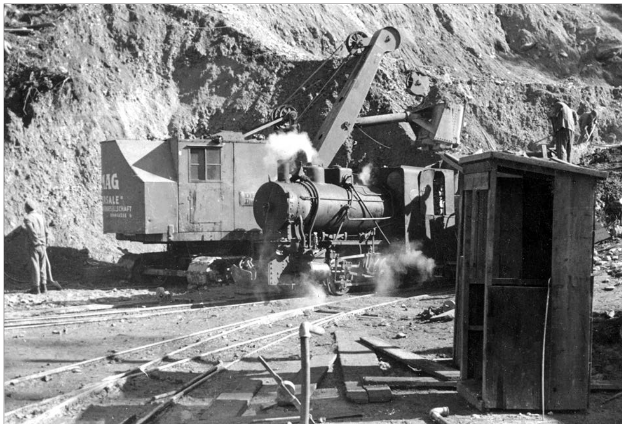
Gradnja tunela (hrani Muzej novejšje zgodovine Slovenije).
