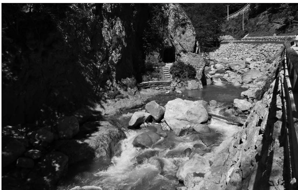
Slika 8: »Obzidana« struga Tržiške Bistrice po sanaciji struge po ujmi oktobra 2018 (foto: Matija Zorn, september 2020).
