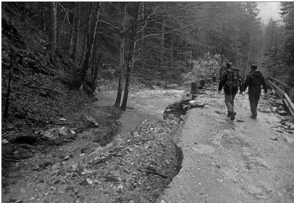
Slika 5: Vodna ujma oktobra 2018 je poškodovala cestno in vodno infrastrukturo (foto: Grega Babun).
