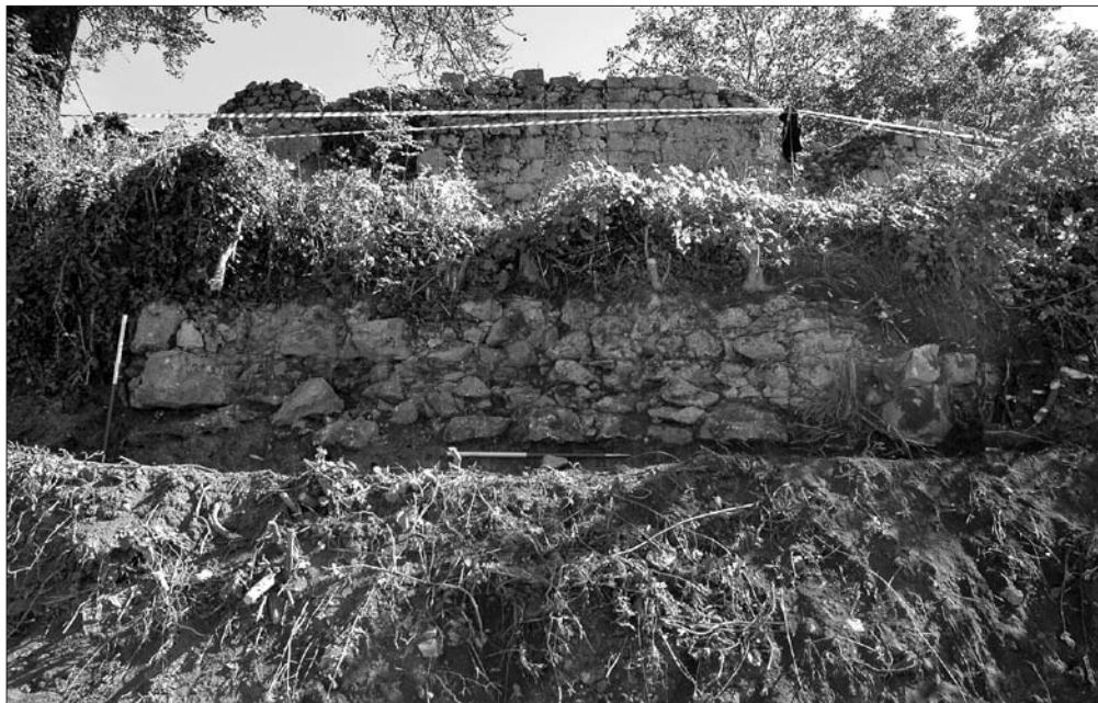
Slika 3: Zunanje lice zidu, nadaljevanje temeljev stolpa (spodaj), srednjeveško mestno obzidje (zgoraj) (foto: F. Aš, ZVKDS, OE Novo mesto).
