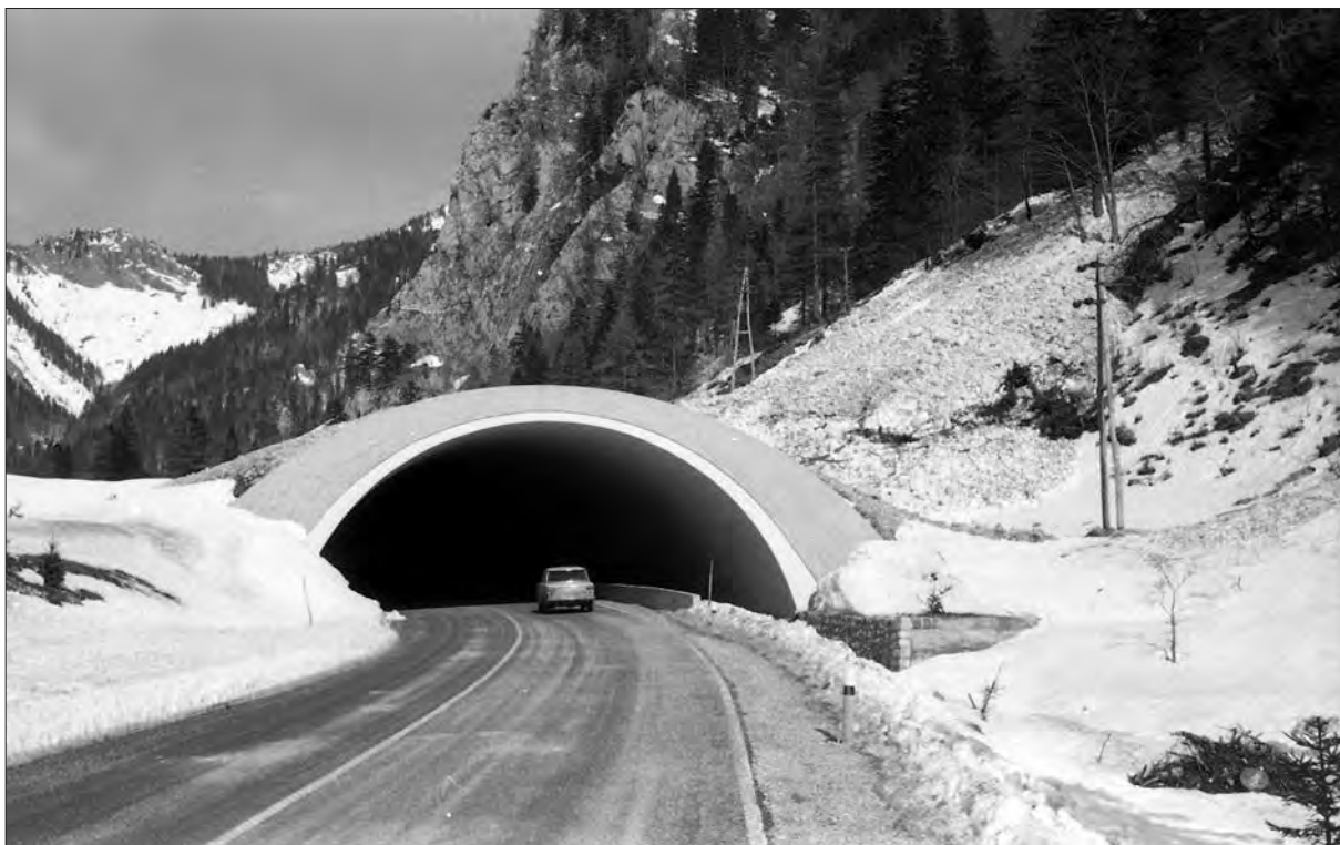
Slika 3: Snežna galerija na cesti proti Ljubelju, na odseku pod Begunjskim plazom, kmalu po zgraditvi (hrani: Jože Pintar).
