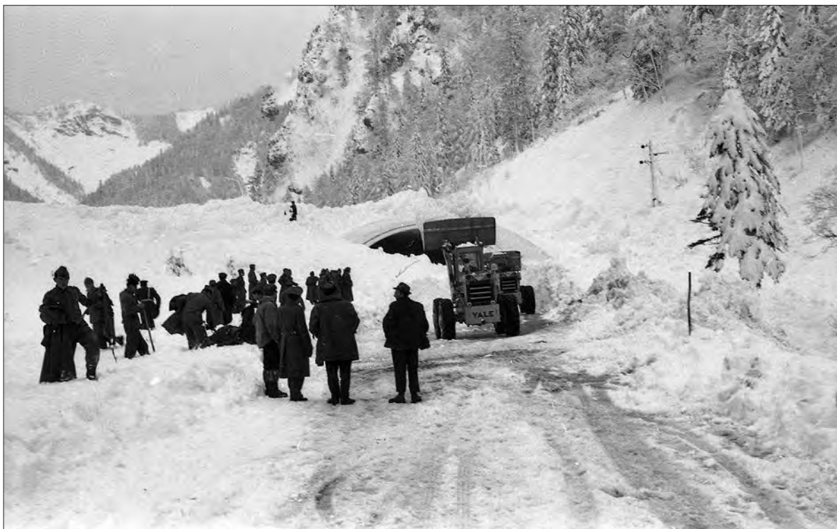
Slika 4: V začetku marca 1965 je snežni plaz zasul snežno galerijo in »pokazal«, da je prekratka. V galeriji je ostalo ujetih več vozil. Slika prikazuje odstranjevanje snega ob spodnjem vhodu v galerijo (hrani: Jože Pintar).
