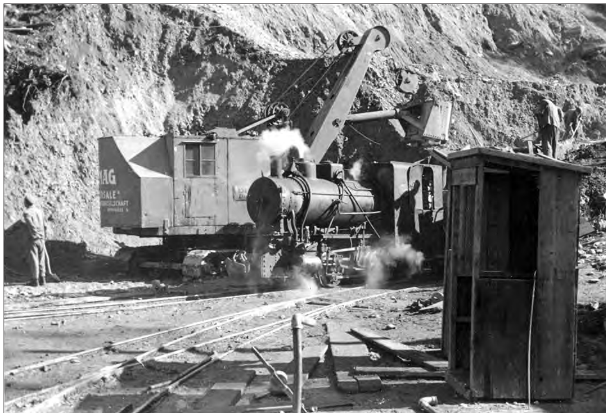
Gradnja tunela (hrani Muzej novejšje zgodovine Slovenije).
