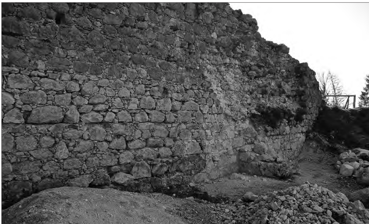
Pogled na dvoriščno stran južnega dela vzhodne stranice obodnega obzidja zgornjega dela gradu z nastavkom nekdanje obzidne stranice s prehodom iz vhodnega grajskega obora v zgornji del gradu (foto: Igor Sapač, 2020).
