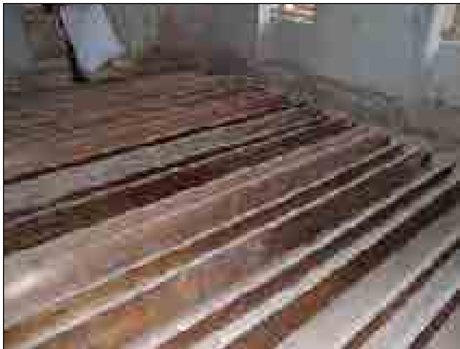
Prešibko leseno stropno konstrukcijo lahko ojačamo z dodatno plohisto obojestransko ojačitvijo.
