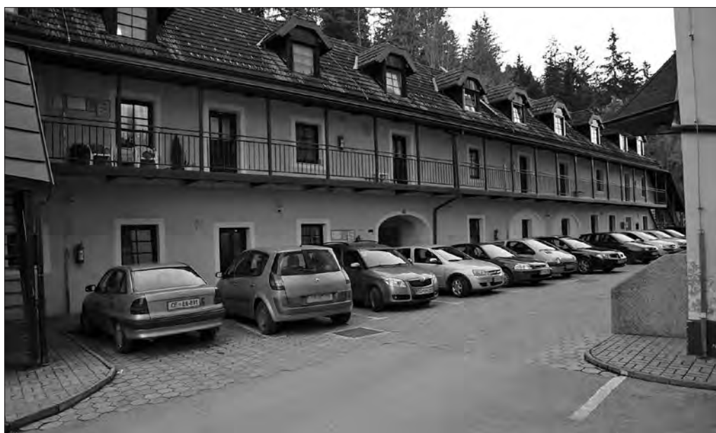
Dvoriščna fasada stranskega trakta dvorca Turn po prenovi (foto: Igor Sapač, 2016).
