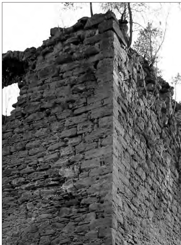
Primerjava strukture konglomeratne zidave glavnega stolpa na gradu Forhtenek (levo), najverjetneje iz okoli leta 1300, in zgornjega bivalnega poslopja v kompleksu gradu Vodriž (desno), najverjetneje iz prve tretjine 14. stoletja (foto: Igor Sapač, 2016 in 2021).
