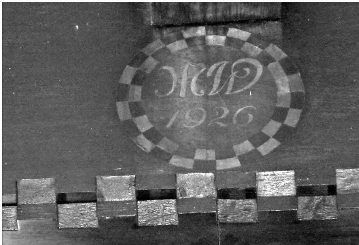
Iniciali MW na stropnem tramu v večji sobani prvega nadstropja (arhiv ZVKDS OE Celje, 2015).
