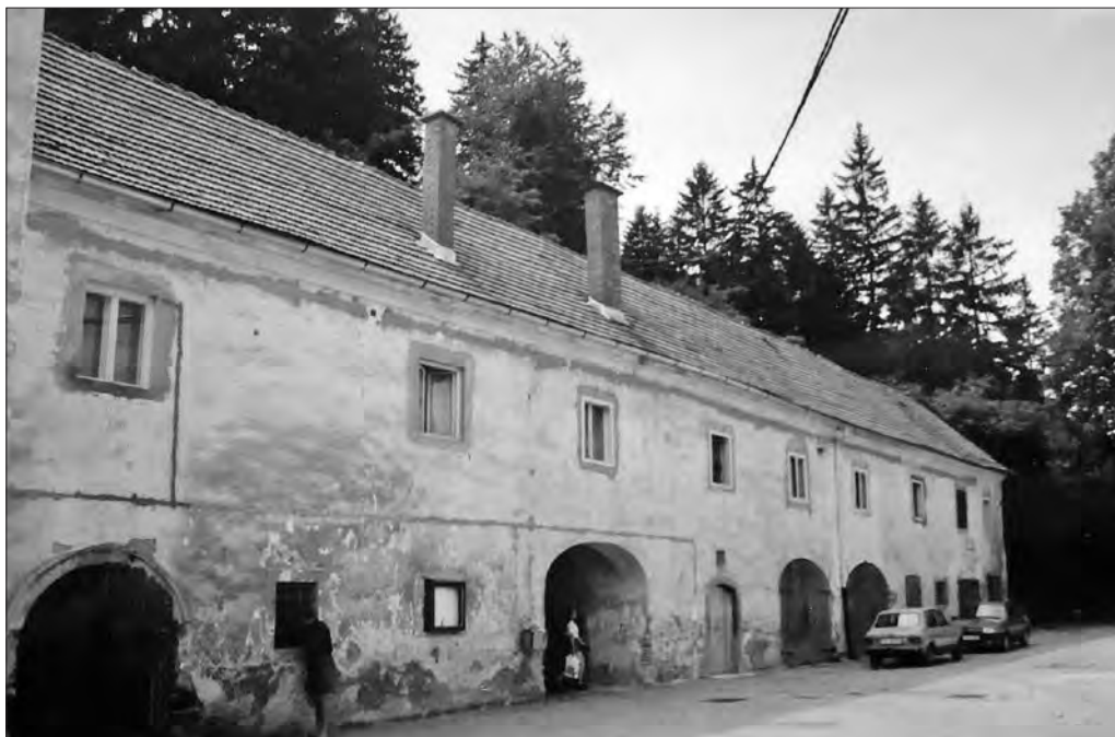
Dvoriščna fasada stranskega trakta dvorca Turn pred prenovo (foto: Igor Sapač, 29. 7. 1997).
