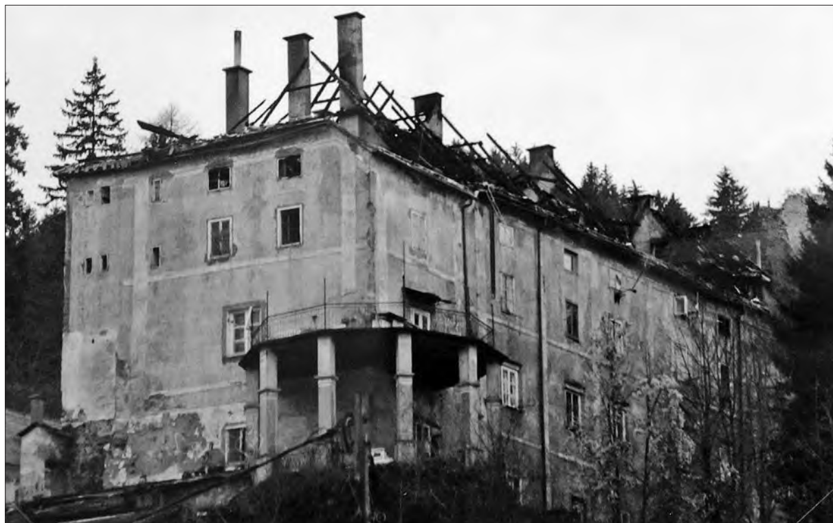
Nekdanji srednjeveški stolpasti dvor na jugovzhodni strani glavnega trakta dvorca Turn po požaru leta 1997 (foto: Igor Sapač, januar 1998).
