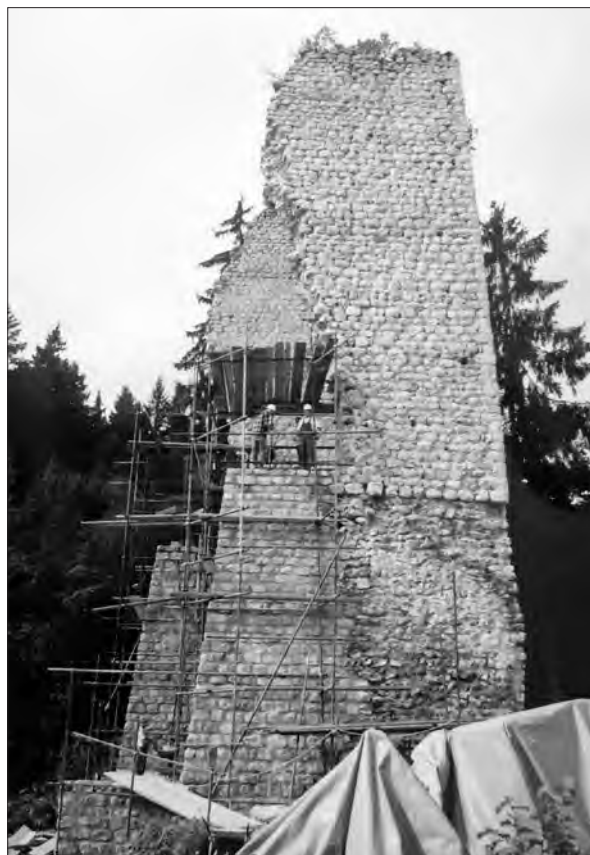
Ostanek glavnega stolpa gradu Šoštanj med sanacijskimi deli z vzhodne strani (foto: Igor Sapač, 9. 9. 1998).
