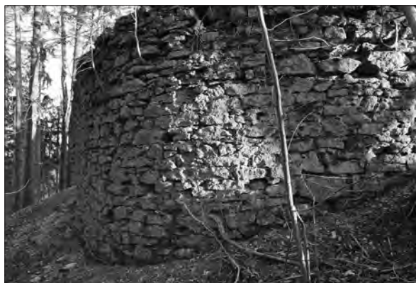
Pogled na zunanjo stran severnega zavoja nekdanjega masivnega obodnega obrambnega obzidja gradu Forhtenek (foto: Igor Sapač, 2016).
