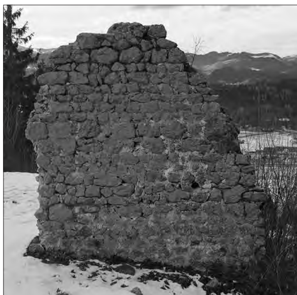
Struktura zidave zahodnega in severnega zidu manjšega poslopja na vzhodni strani grajskega kompleksa, ki so ga postavili nad porušeno starejšo stavbo (foto: Igor Sapač, 2021).
