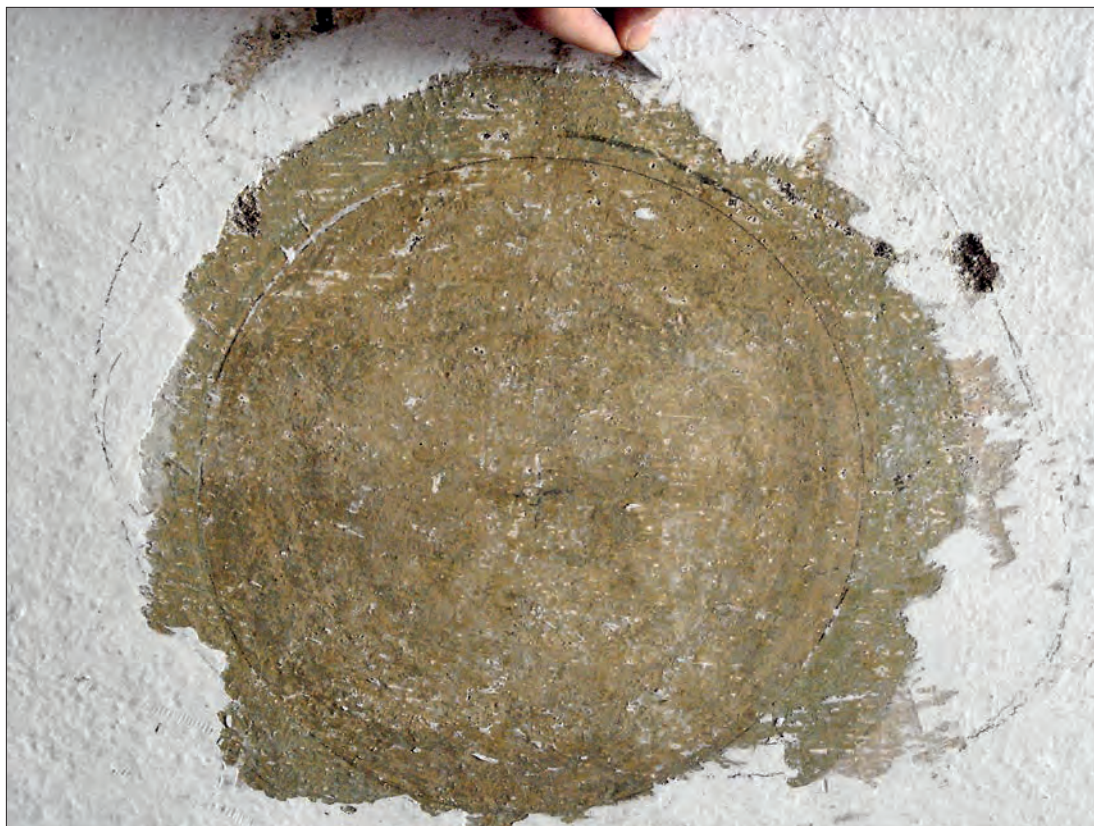
Sondiranje in priprava na restavratorske posege.
