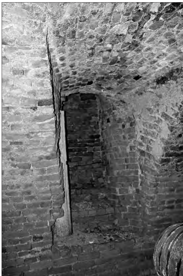
Prvotni vhod v klet gradu Branek, ki so ga v 18. stoletju z zunanje strani zazidali, in pogled na del ometane obočne konstrukcije v severozahodnem prostoru pritličja nekdanjega osrednjega trakta gradu Branek (foto: Klavdija Vnuk, 2015).
