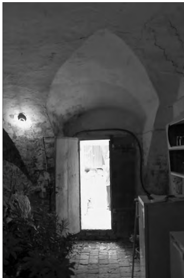
Prvotni vhod v klet gradu Branek, ki so ga v 18. stoletju z zunanje strani zazidali, in pogled na del ometane obočne konstrukcije v severozahodnem prostoru pritličja nekdanjega osrednjega trakta gradu Branek (foto: Klavdija Vnuk, 2015).
