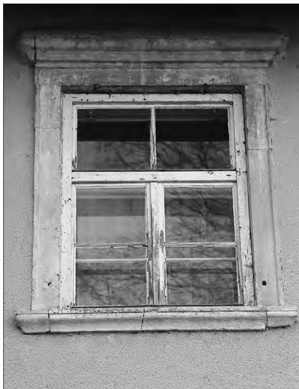
Zgodnjebaročna kamnita okenska okvirja v prvem nadstropju severovzhodne fasade nekdanjega gradu Branek. Nekdanje železne kovane mreže so odstranili med izdelavo novih fasadnih ometov leta 1990 (foto: Igor Sapač, 2022).
