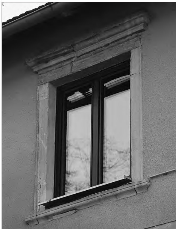
Zgodnjebaročna kamnita okenska okvirja v prvem nadstropju severovzhodne fasade nekdanjega gradu Branek. Nekdanje železne kovane mreže so odstranili med izdelavo novih fasadnih ometov leta 1990 (foto: Igor Sapač, 2022).
